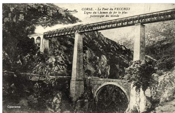
Gustave Eiffel achève la construction du viaduc ferroviaire de Venaco en Haute Corse
